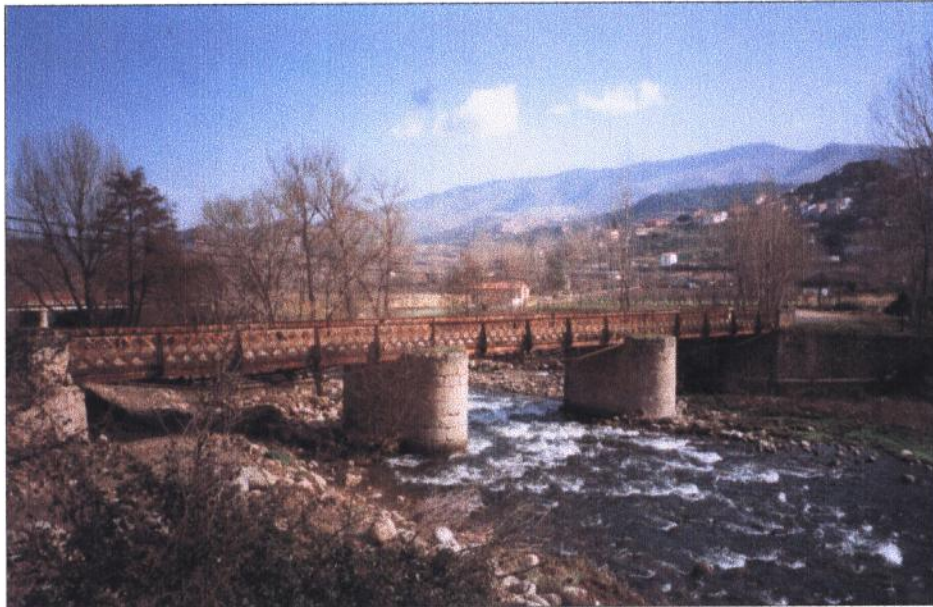
Puente metálico. Año 1.879
