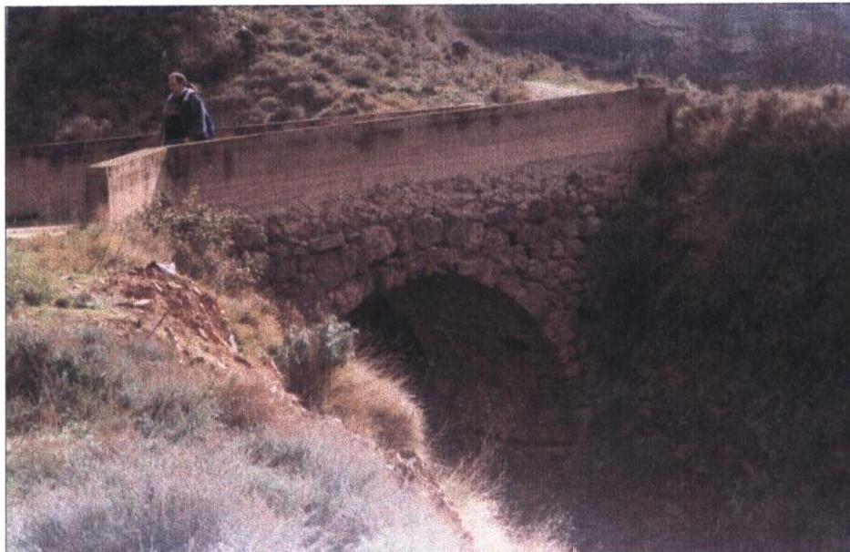
Puente sobre el río Mayor
